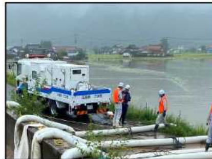
排水施設の整備
