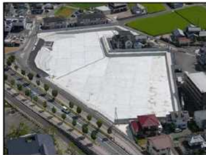
雨水貯留浸透施設の整備、改良
