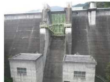
放流設備の改修(塗装、水密ゴム交換)
