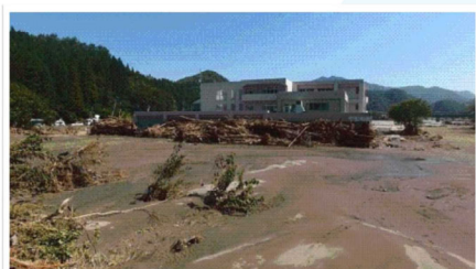
平成28年台風第10号による被害状況
