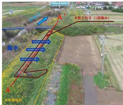
①堤防天端からの漏水
