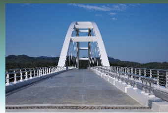
気仙沼大島大橋 舗装工事前の状況
