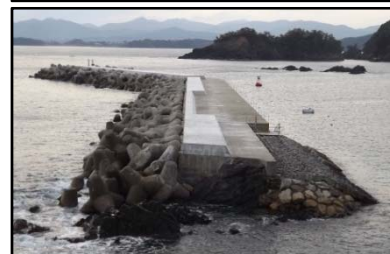
完成(嵩上げ後)
