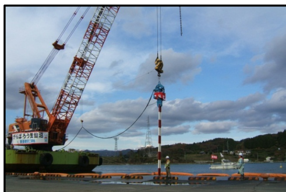
復旧工事着工（鋼矢板打設）
