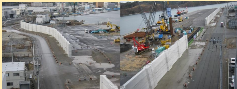
気仙沼港朝日岸壁復旧後の利用状況
