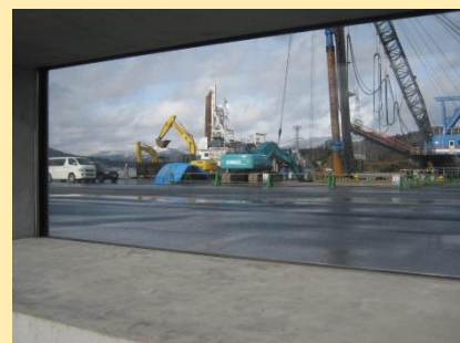
アクリル窓の陸側から見た朝日岸壁
