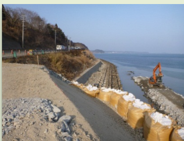
【H26.3月現在:仮設道路工事状況】
