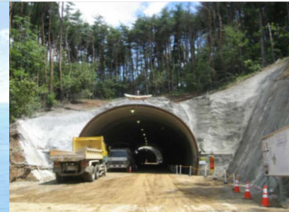
【(仮)磯草5号・4号トンネル掘削状況 (手前が5号, 奥が4号トンネル)】
