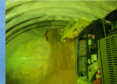
【(仮)磯草5号トンネル掘削状況】
