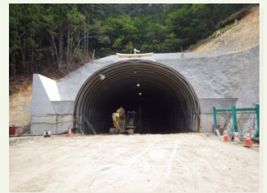
【トンネル坑口部】
