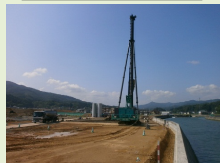
【H26.6月現在地盤改良施行状況】
