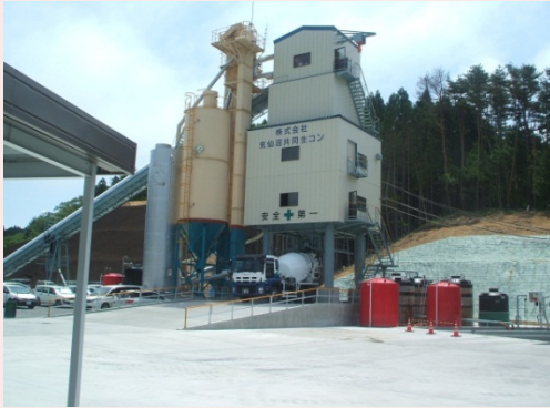
完成したプラント全景
