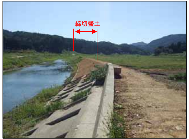
①応急工事 締切盛土 施工完了
