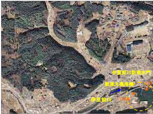
伊里前川河口防潮水門右岸破堤
