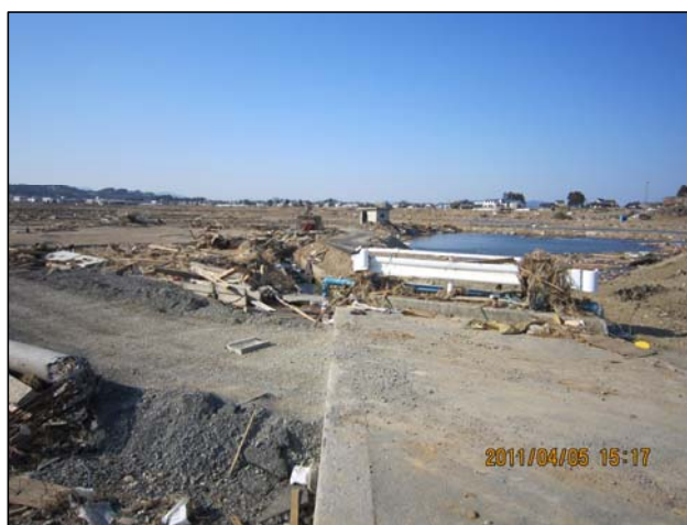
⑤防潮水門背後被災状況
