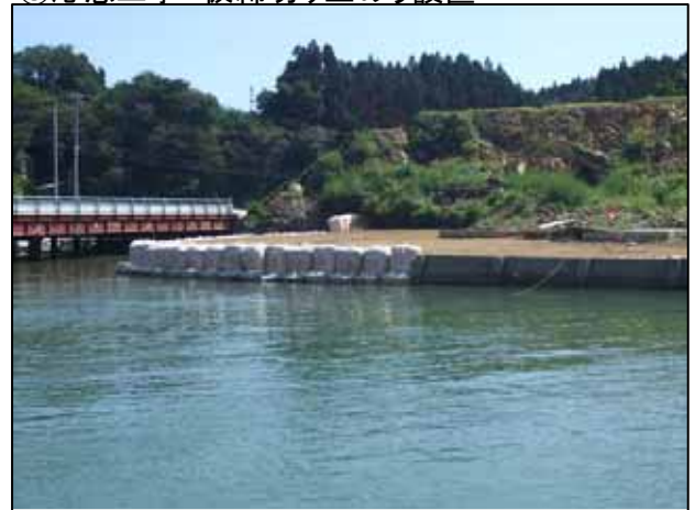
③応急工事 仮締切り土のう設置
