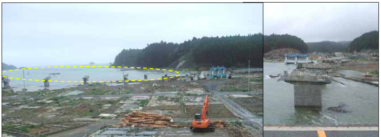
歌津大橋落橋落橋
