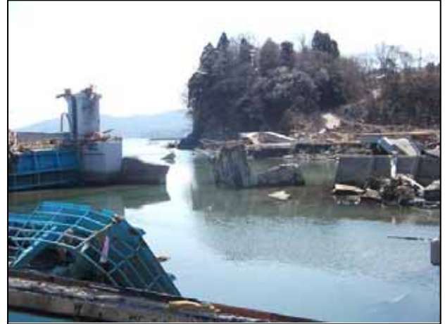
②河口右岸部 護岸崩壊・破堤
