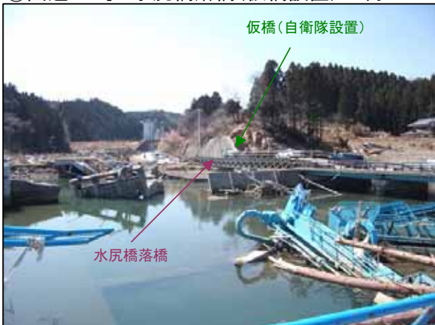
④国道45号 水尻橋落橋(仮橋設置)/4月
