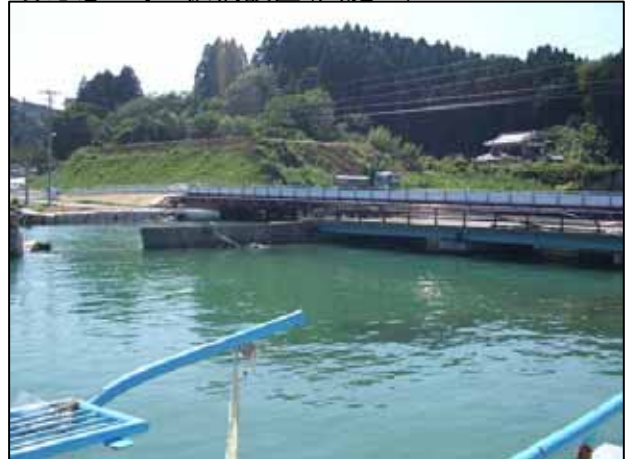
④応急工事 仮橋設置(国施工)
