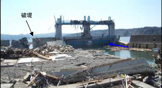
新井田川防潮水門全損
