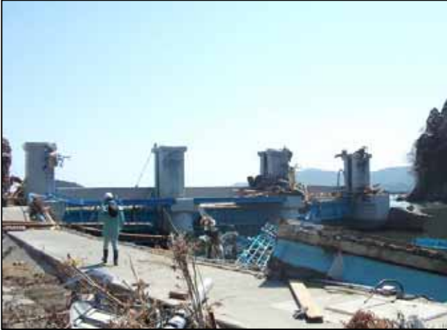
③河川護岸破損及び左岸部破堤
