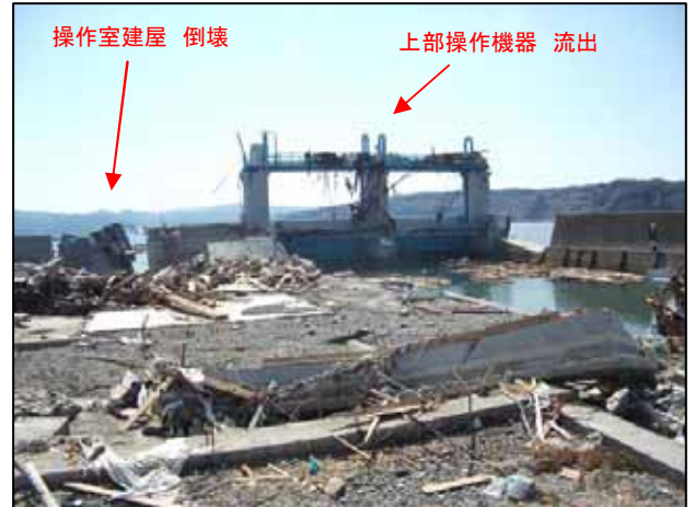
①新井田川防潮水門全損
