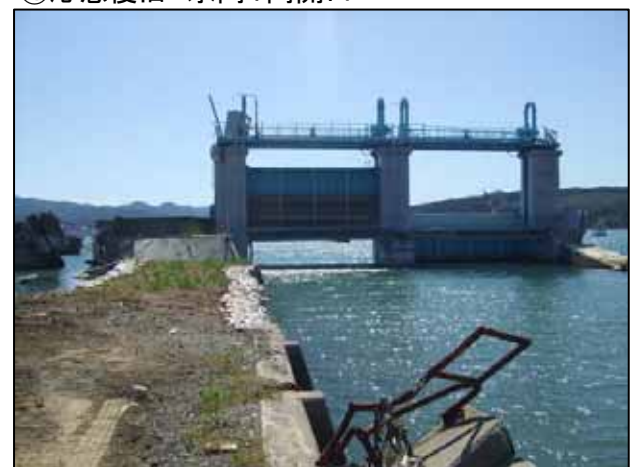
④応急復旧 水門1門開口
