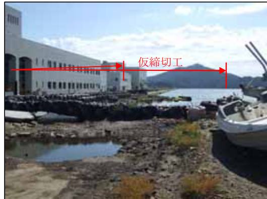
①応急工事 仮締め切り土のう設置
