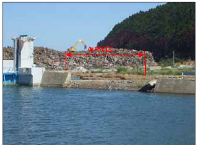
③応急工事 仮締め切り盛土設置
