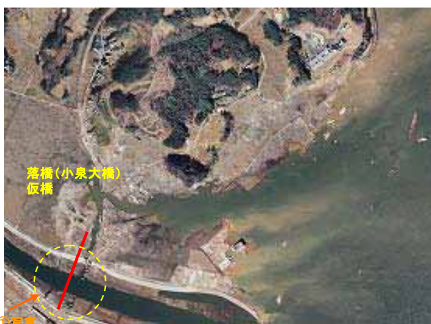
小泉大橋落橋
