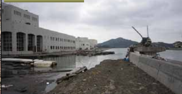
大川左岸 護岸破損
