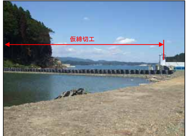
②応急工事 仮締め切り土のう設置
