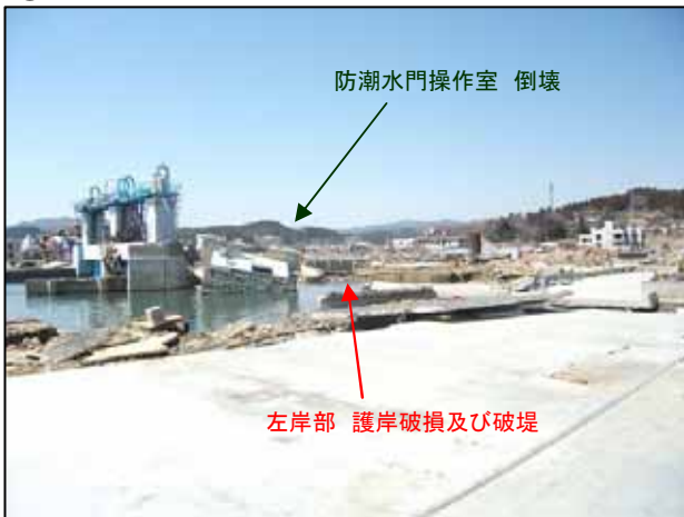
②河口部 左岸護岸破損・破堤
