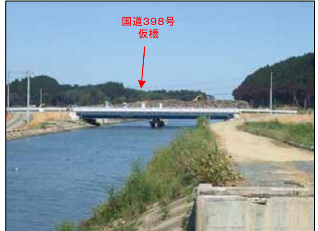
②応急工事 仮橋設置
