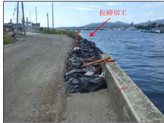
③応急工事 仮締め切り土のう設置
