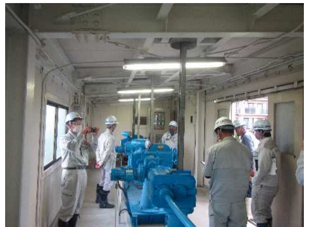
【訓練内容の説明・杉ヶ崎樋門】
