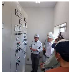
【百々川排水機場 操作手順の確認状況】
