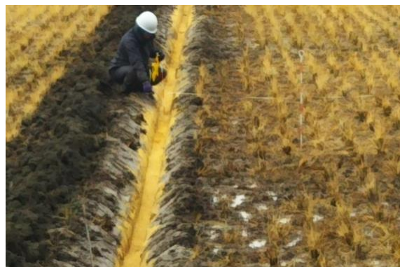
【暗渠施工（排水対策）】
