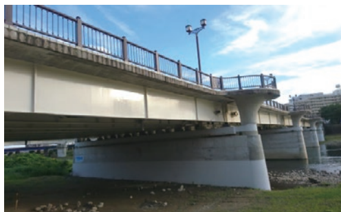
現在の広瀬橋(バルコニー)
