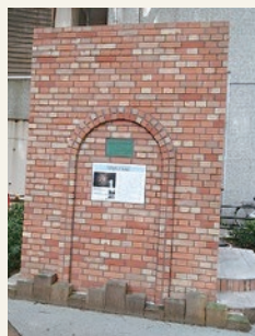
下水道施設入口
