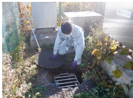
長沼ダム漏水調査の手順確認の様子
