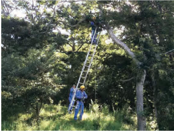
ワイヤー張り作業
