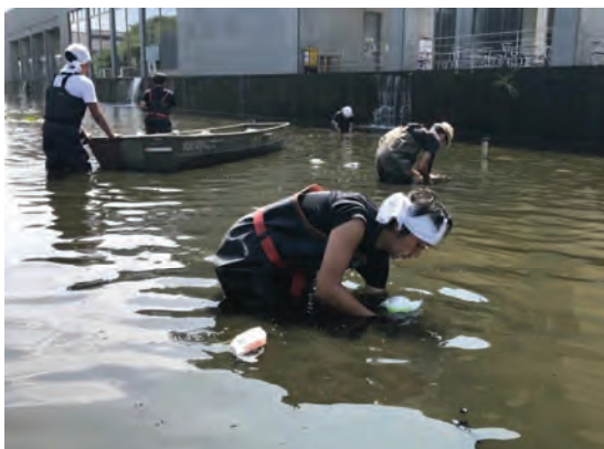
池へ沈める作業
