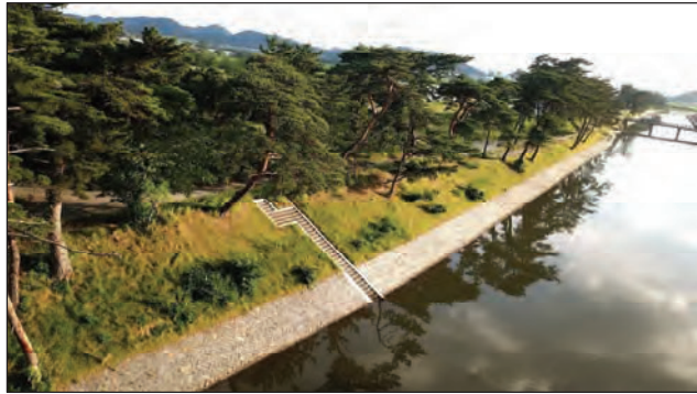
【東名運河 工事完成 松並木の保全】
