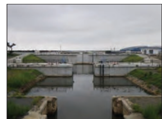
【釜閘門 工事完成】
