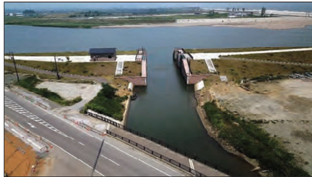
【野蒜水門 工事完成】
