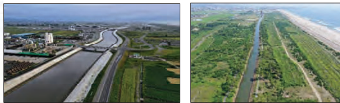
【新堀 工事完成】
