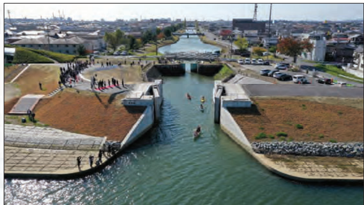
【石井水門 完成式典の様子】
