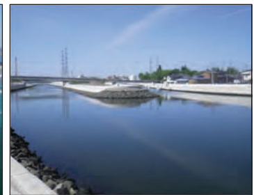
【御舟入堀工事 完成 旧砂押川】
