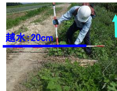
越水写真(痕跡)
