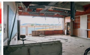
津波は防風林の松などを巻き込みながら校舎を突き抜け、2階天井まで達した。
