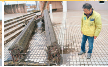
津波によって折れ曲がった時計台。津波の威力の恐ろしさがうかがえる。
