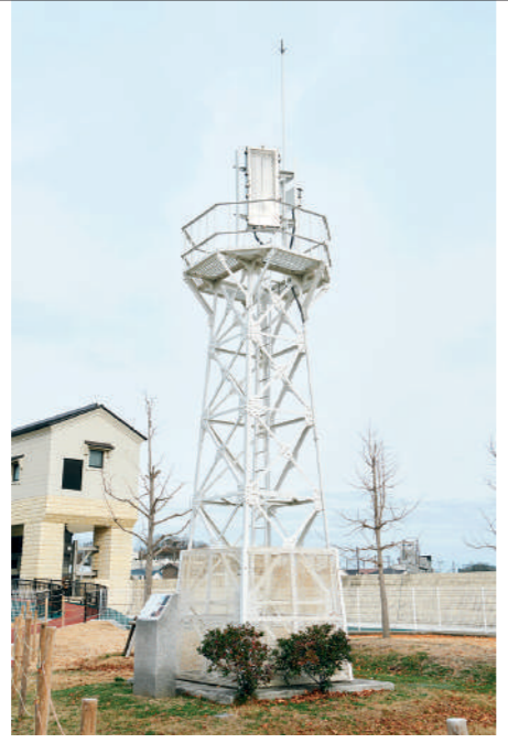
船舶を安全に導く導灯は2基（前灯・後灯）一対。航路変更に伴い平成26年に廃止された塩釜導灯は94年間夜の航路を照らし続けました。写真は前灯上部7メートル。
