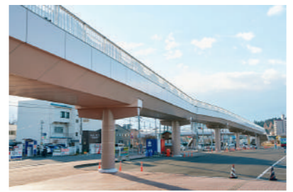
マリングート塩釜、さらに本塩釜駅方面を繋ぐ遊歩道「津波避難デッキ」。高さ5メートル超、長さ372メートル。
