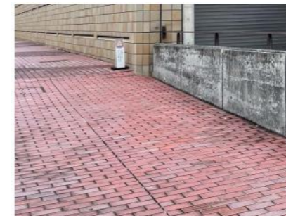
西側通路の路面
