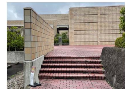
駐車場から前庭に続く階段
