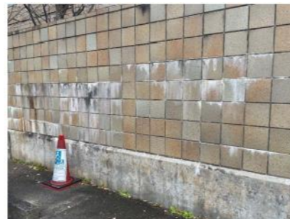
駐車場に隣接した塀
