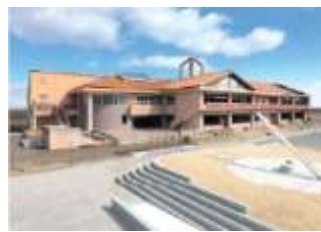
震災遺構中浜小学校 (山元町)
