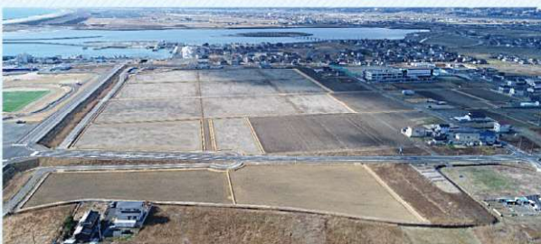
荒浜北部地区（亶理町）整備後の農地
