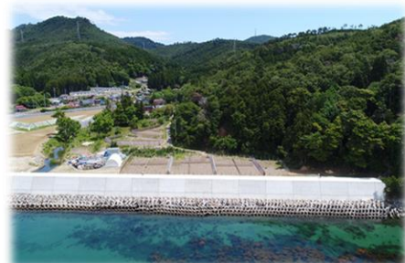
復旧した防潮堤
