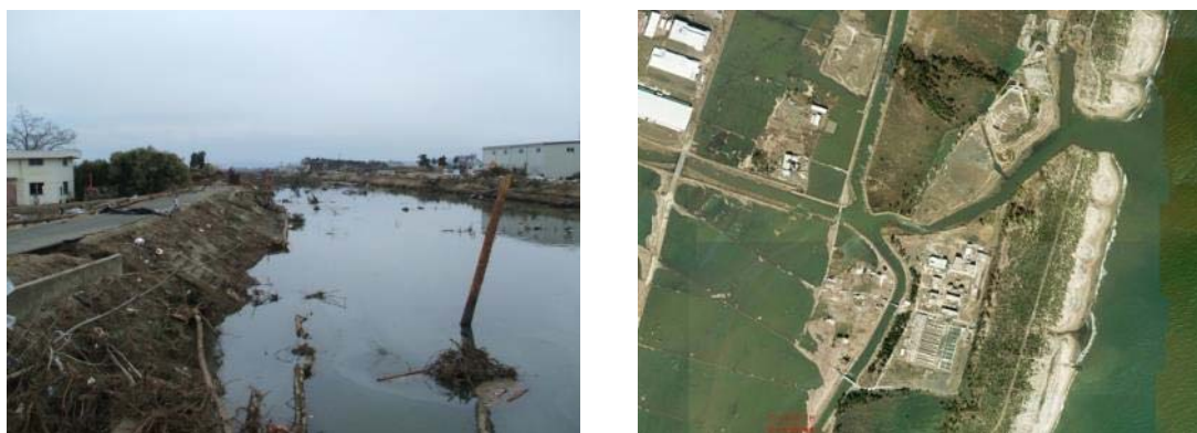
写真 1.2 木曳堀の被災状況 左:岩沼市下野郷地区 右:海と通じた赤井江(平成 23(2011)年 3 月 12 日 国土地理院撮影)
