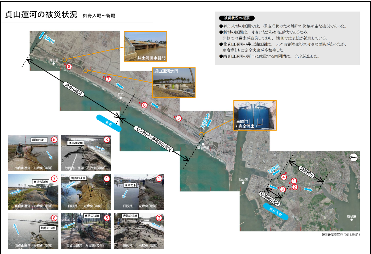
図 1.5 貞山運河の被災状況 御舟入堀～新堀 [出典:河川課資料]
