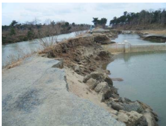
写真 1.7 北上運河(鳴瀬川水系北上運河, 定川水系北北上運河, 南北上運河)の被災状況 上左: 釜閘門(海側) 上右: 北北上運河の破堤 下左: 北上運河の堤防裏法面(陸側)の洗掘 下右: 南北上運河
