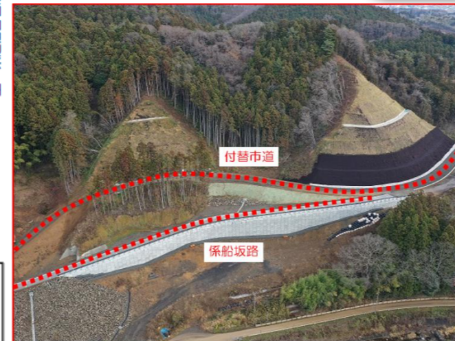
【道路改良工事（その4）完成！】
