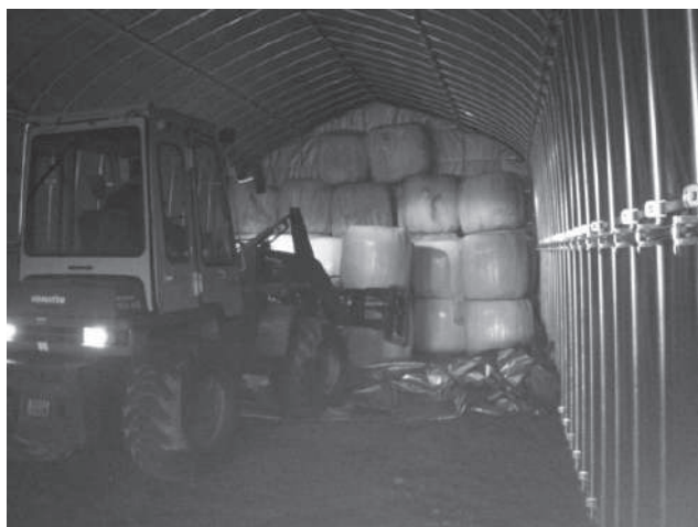
写真 一時保管施設への搬入作業（登米市）
