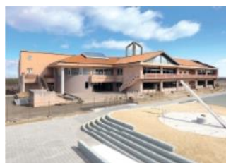
震災遺構中浜小学校 (山元町)
