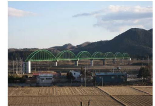
< 阿武隈川水管橋 >
