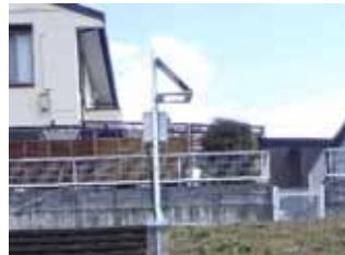
危機管理型水位計 (荒川・村田町)
