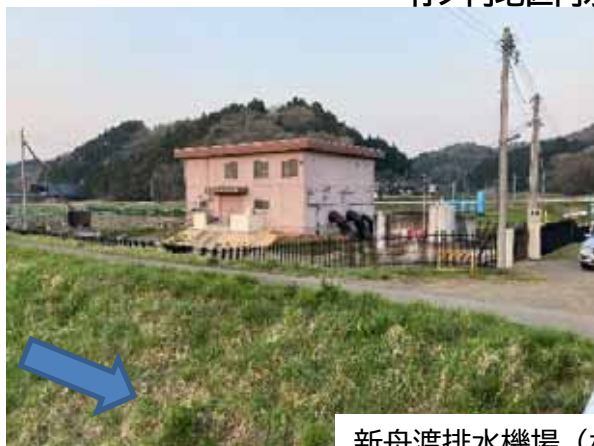
新舟渡排水機場 (村田町)
