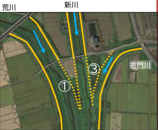
①荒川 左岸 (新川合流付近)
