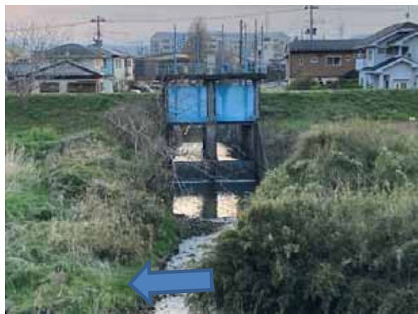
青川樋管 (大河原町)
