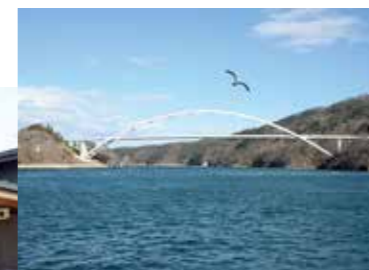
気仙沼大島と本土側を結ぶ気仙沼大島大橋
