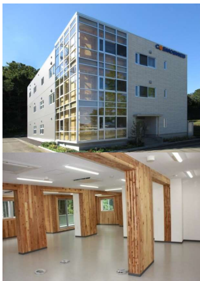
【事例1】株式会社コスモスウェブ（事務所） CLTパネル工法（ルート2） 県内初の3階建CLT建築
