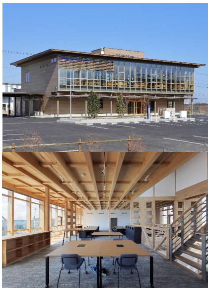
【事例2】東北ボーリング株式会社（事務所） 在来軸組工法+CLT CLTを2F床と屋根に活用
