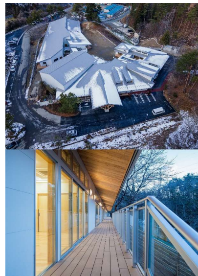
【事例3】みやの森こども園（幼保施設） 在来軸組工法+CLT CLTを屋根に活用
