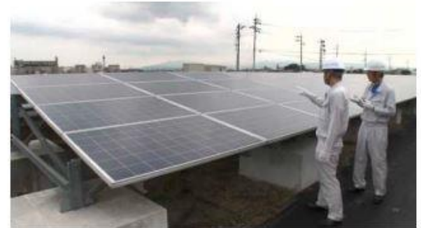
太陽電池モジュールの外観検査の例
