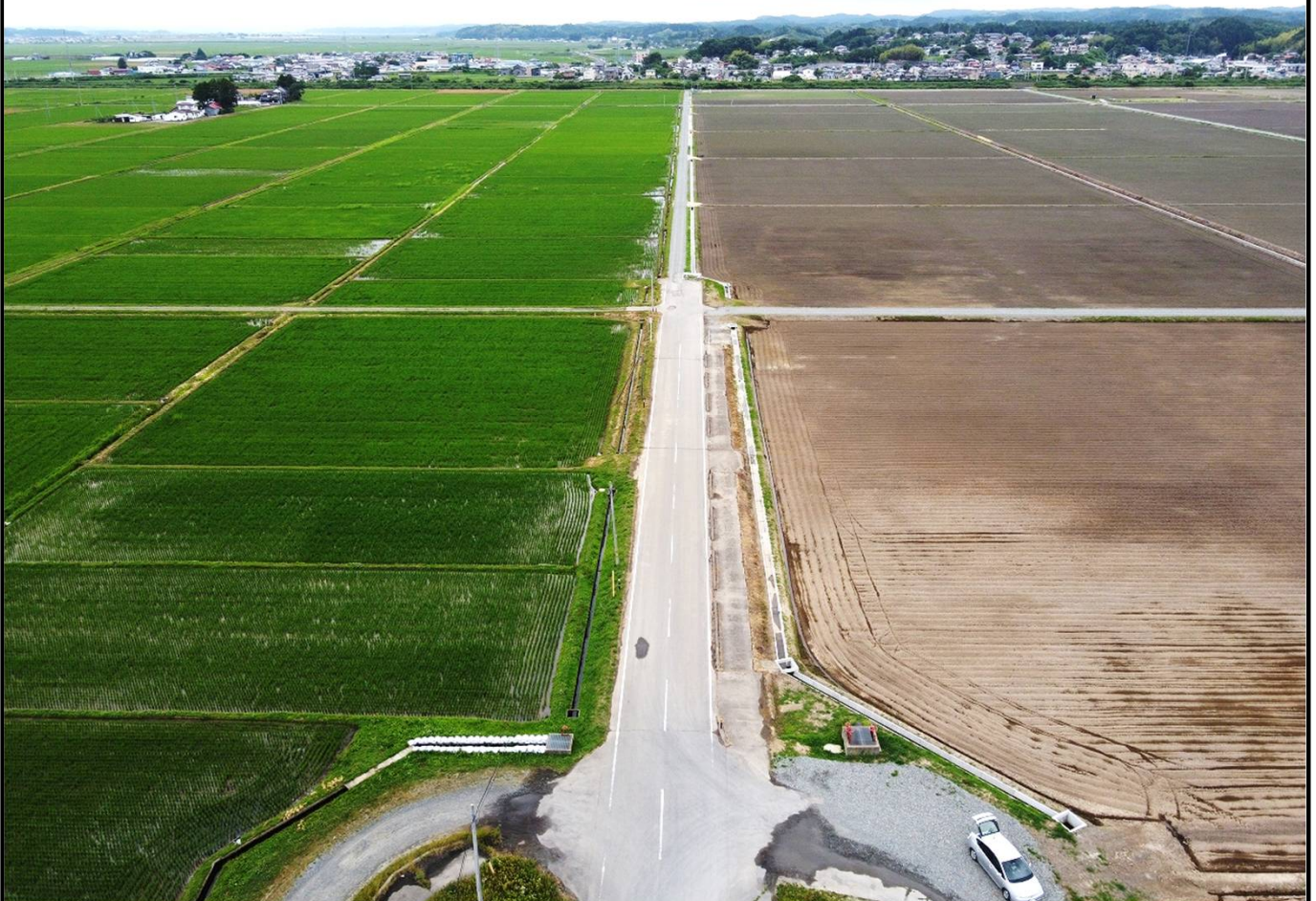
▲ほ場整備前後対比写真 道路を挟んで左が整備前、右が整備後の農地 (R3.6月大崎市)
