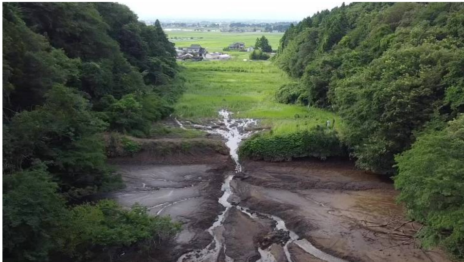
▲令和4年7月豪雨で決壊した 稲荷沢1号ため池(大崎市)
