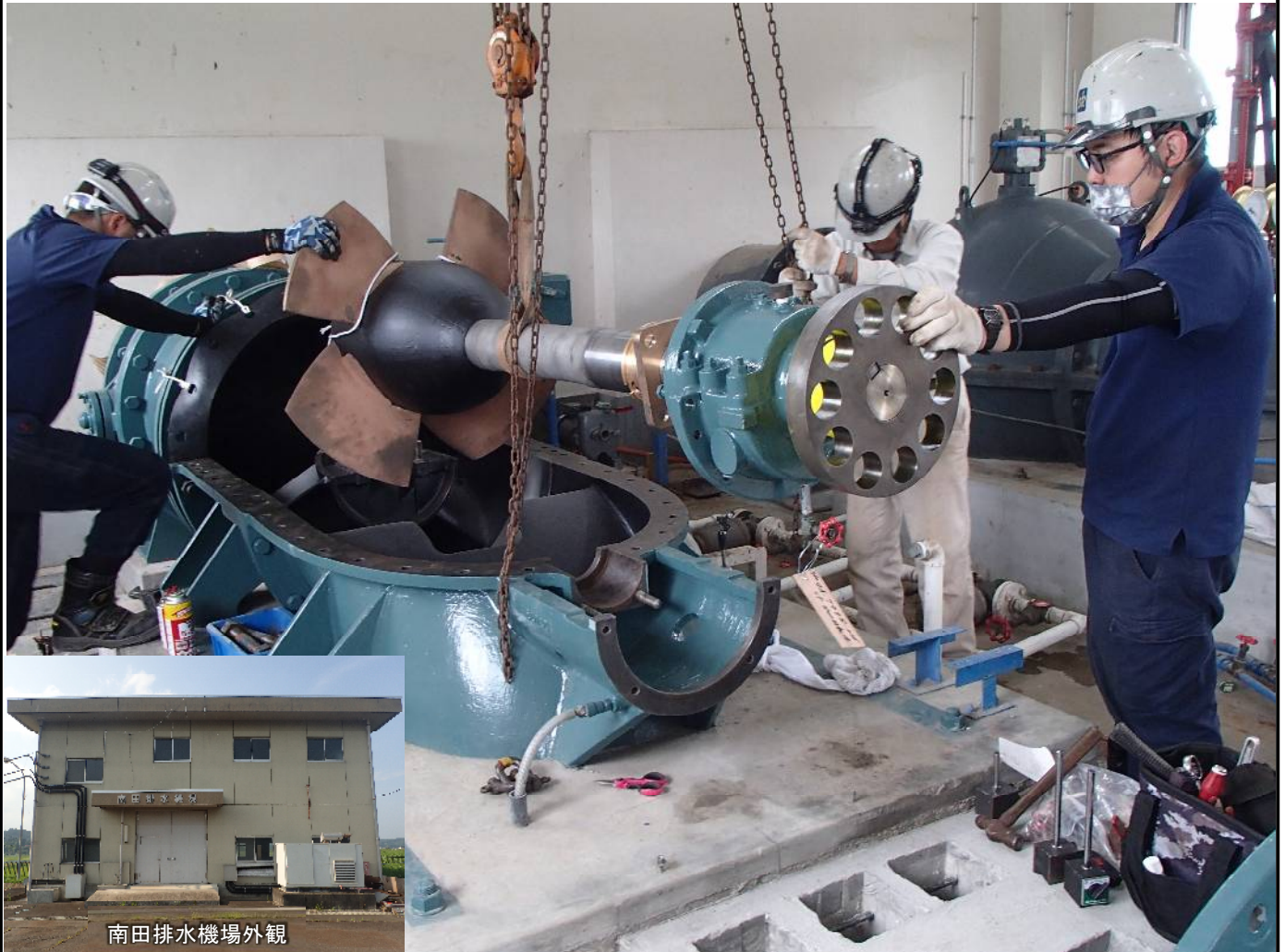
▲南田排水機場2号ポンプ回転体据付状況(R3.6村田町)
