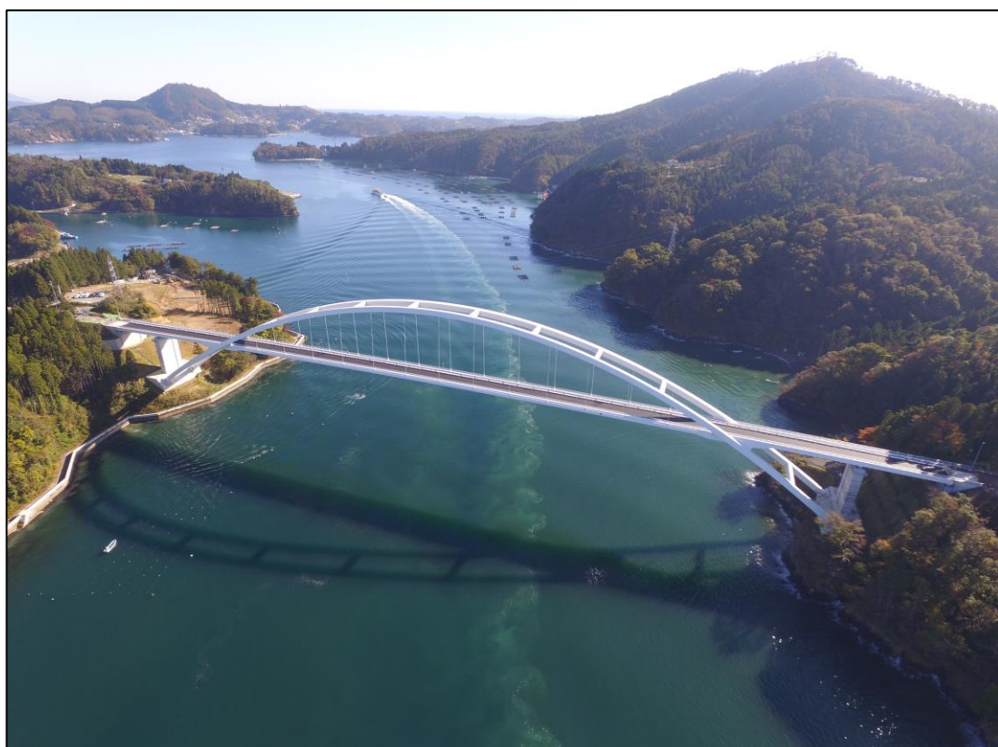
気仙沼大島大橋全景
