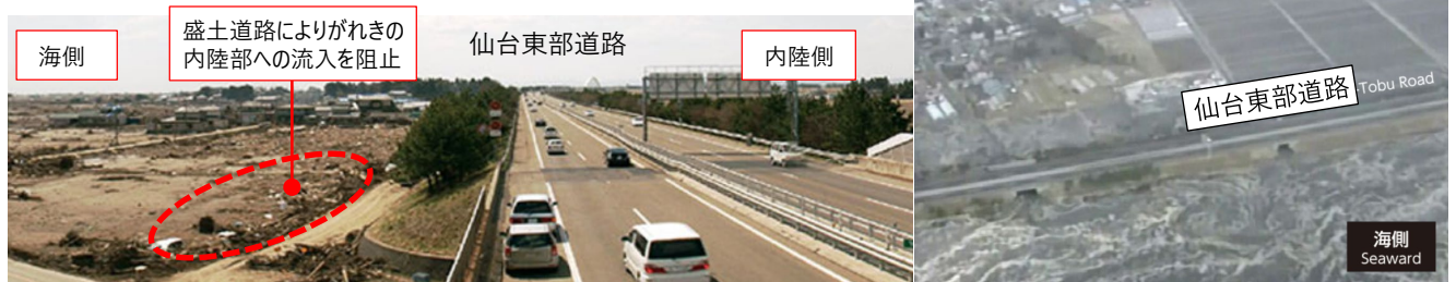
図-3.4 東日本大震災における盛土道路の津波防護施設としての効果
