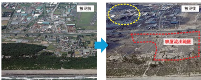
図-2.12 仙台湾沿岸低平地の被災状況
