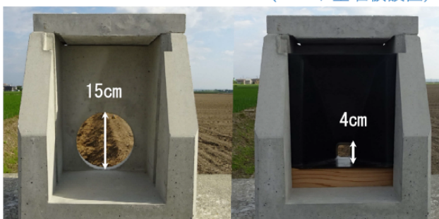
田んぼダム型排水柵 (ロート型堰板設置)
