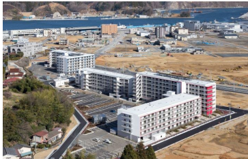
津波避難ビルとして位置づけられている災害公営住宅（気仙沼市南気仙沼地区）
