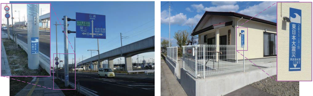
図 5-3 津波浸水表示板の設置状況
