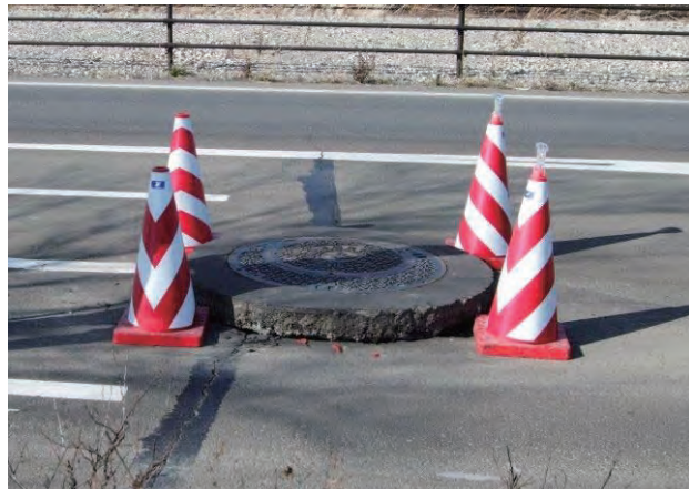
図 4-14 道路啓開状況（左）、マンホールの突出（右）
