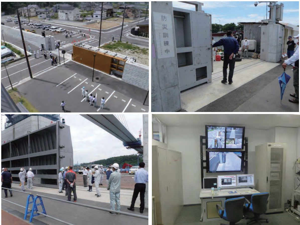
図 4-43 水門陸閘自動閉鎖システム 操作訓練状況(令和2(2020)年6月12日実施)
