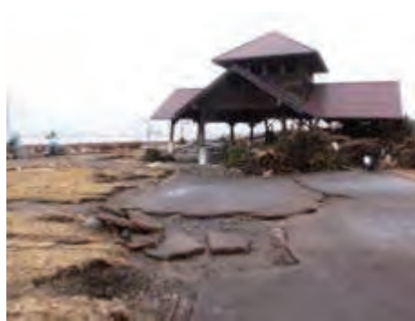
図 4-59 岩沼海浜緑地被災状況
