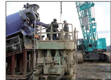
白浜地区海岸災害復旧工事 「場所打ち杭コンクリート打設状況」
