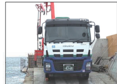
狐崎漁港北防波堤災害復旧工事 「防波堤コンクリート打設状況」
