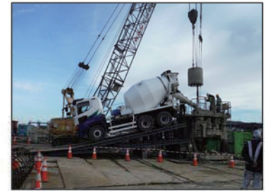
折立川河川災害復旧工事 「場所打ち杭コンクリート打設状況」
