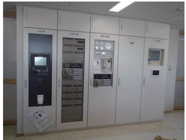
図 3-128 校舎棟 屋外キュービクル(左)・複合防災盤(右)
