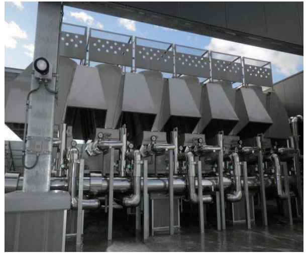
図 3-136 機械室内部(左)・屋上チラーユニット(右)
