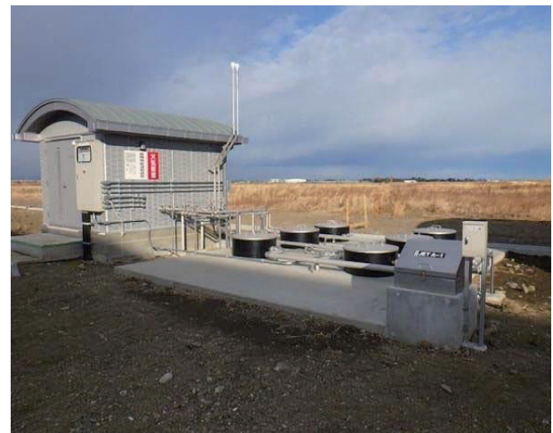
図 3-123 粉末消火ポンプ(左)・地下タンク，ポンプ室(右)
