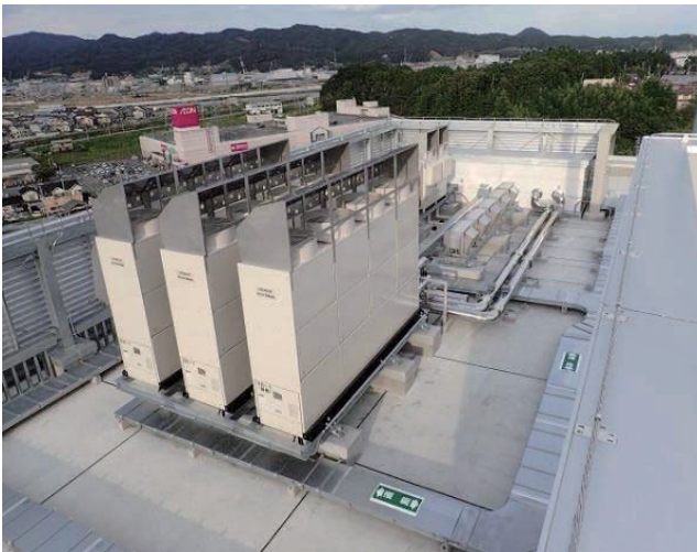
図 3-143 エアハンドリングユニット(左)・冷温水用ヘッダー(右)
