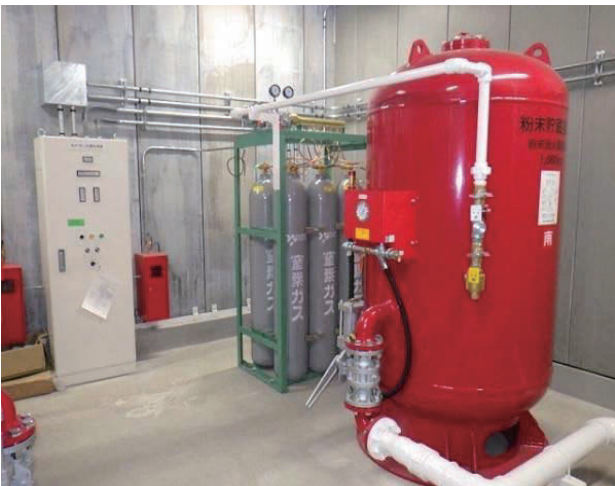
図 3-123 粉末消火ポンプ(左)・地下タンク，ポンプ室(右)
