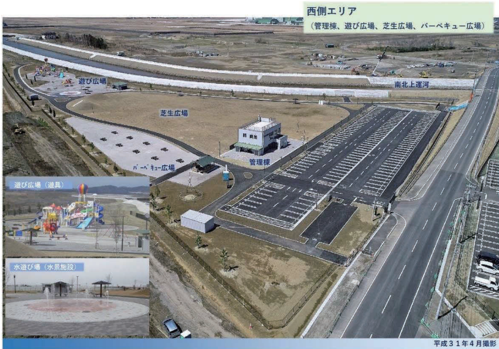
図 3-156 矢本海浜緑地の復旧状況
