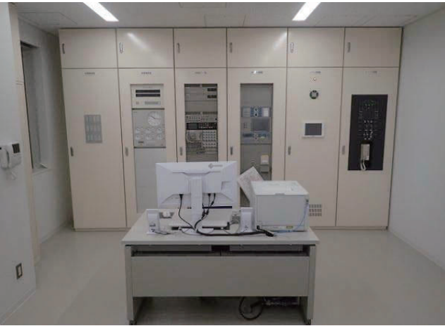
図 3-134 非常用放送設備等(左)・電気室キュービクル(右)
