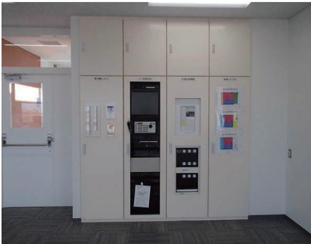
図 3-121 総合防災盤(左)・受変電設備(右)
