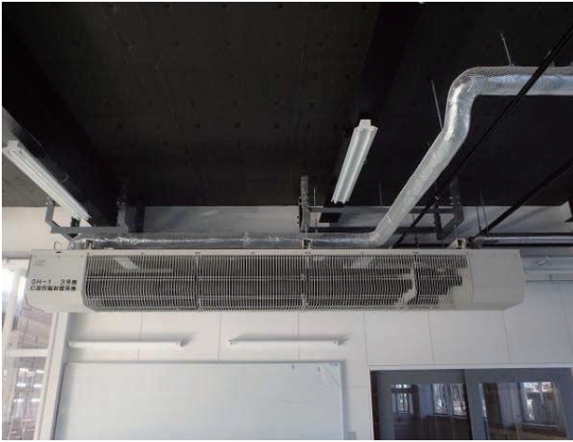
図 3-130 6次産業化ゾーン 輻射式暖房機(左)・鶏舎卵自動収集洗浄装置(右)
