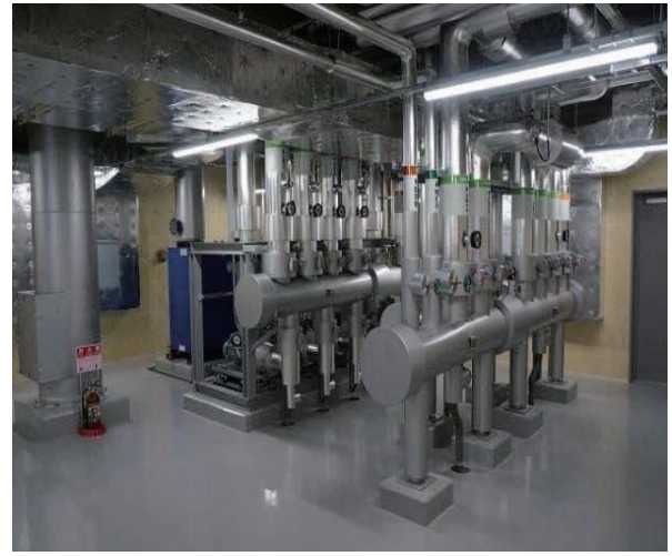
図 3-143 エアハンドリングユニット(左)・冷温水用ヘッダー(右)
