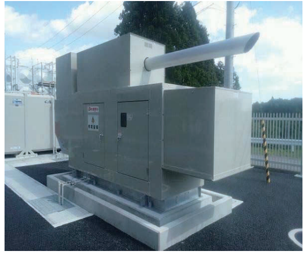
図 3-141 受変電設備(左)・自家発電設備(右)
