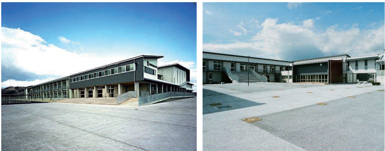
図 3-125 農業高校 校舎棟 外観写真
