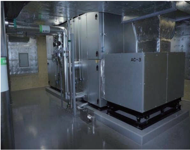
図 3-143 エアハンドリングユニット(左)・冷温水用ヘッダー(右)
