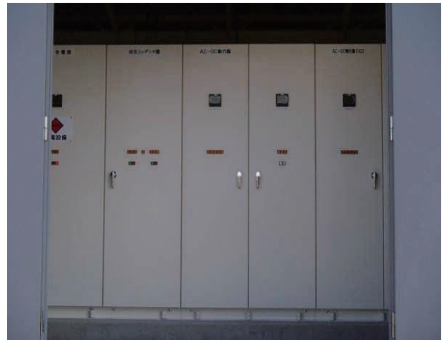
図 3-121 総合防災盤(左)・受変電設備(右)
