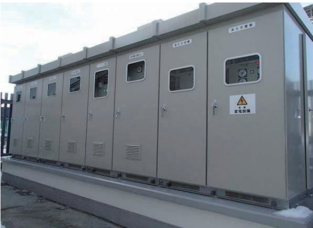
図 3-128 校舎棟 屋外キュービクル(左)・複合防災盤(右)
