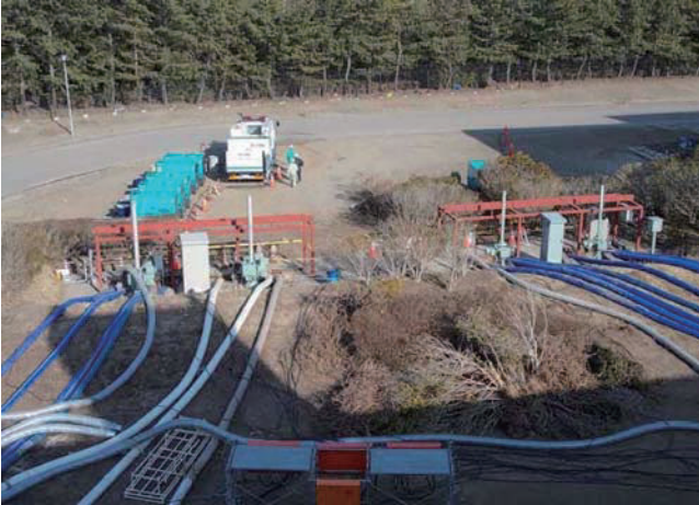
図 3-78 仮設ポンプ設置状況（仙塩浄化センター）
