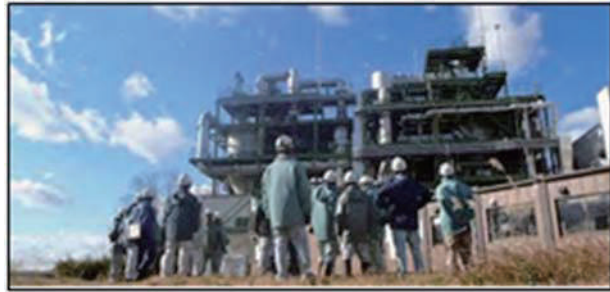
図 3-96 平成 24 (2012) 年 12 月 汚泥焼却施設の試運転開始
