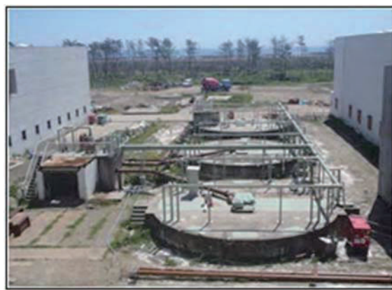
図 3-100 重力濃縮設備の復旧状況
