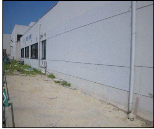
図 3-91 ポンプ場の窓閉鎖による津波対策（耐水化）【県南浄化センター】
