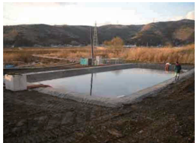
図 3-89 真野川 仮設沈殿池
