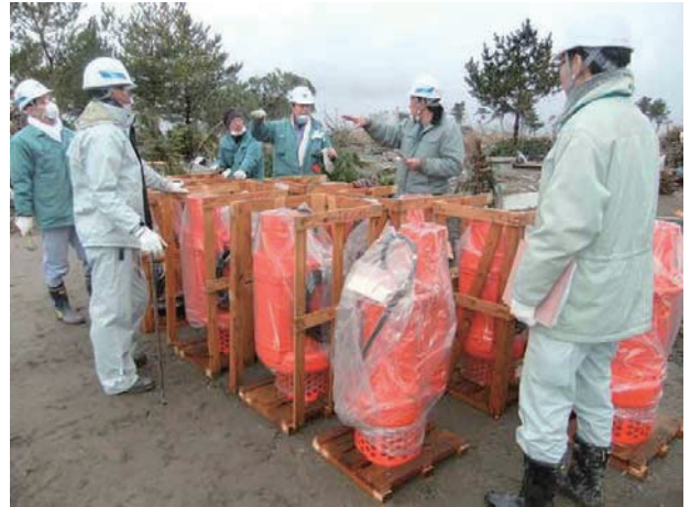
図 3-79 作業状況（県南浄化センター）
