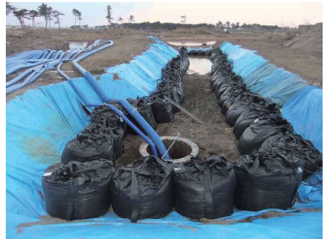
図 3-11 緊急排水状況（県南浄化センター）
