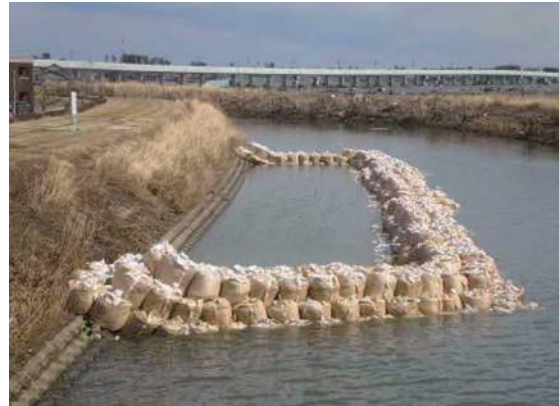
図 3-87 増田川 仮設沈殿池
