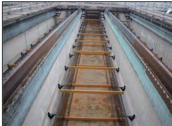
図 3-102 第 3 系列 最終沈殿池復旧状況
