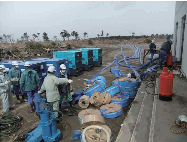
図 3-80 作業状況（県南浄化センター）
