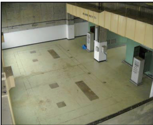
図 3-93 電気設備を2Fへ移動したことによる津波対策（高層化）【石巻東部浄化センター】
