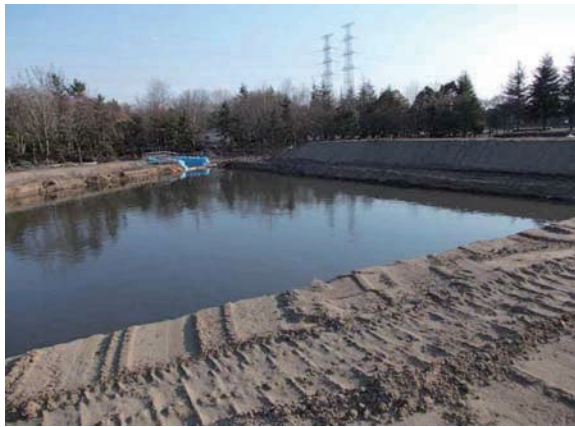
図 3-84 多賀城緩衝緑地公園内 仮設沈殿池
