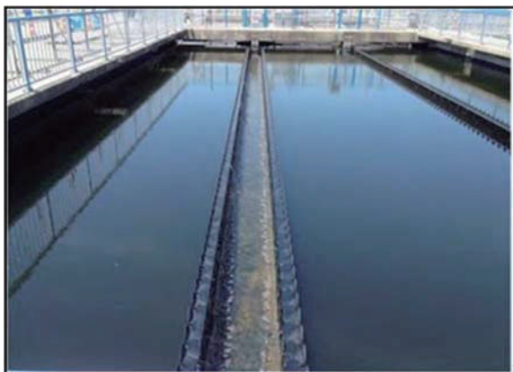
図 3-99 第 4 系列水処理の復旧状況
