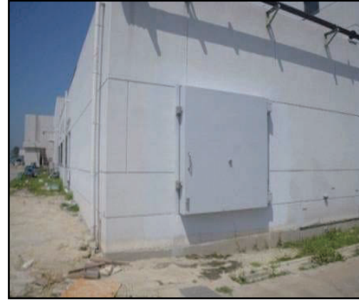
図 3-92 施設出入口を耐水扉とした津波対策（耐水化）【県南浄化センター】
