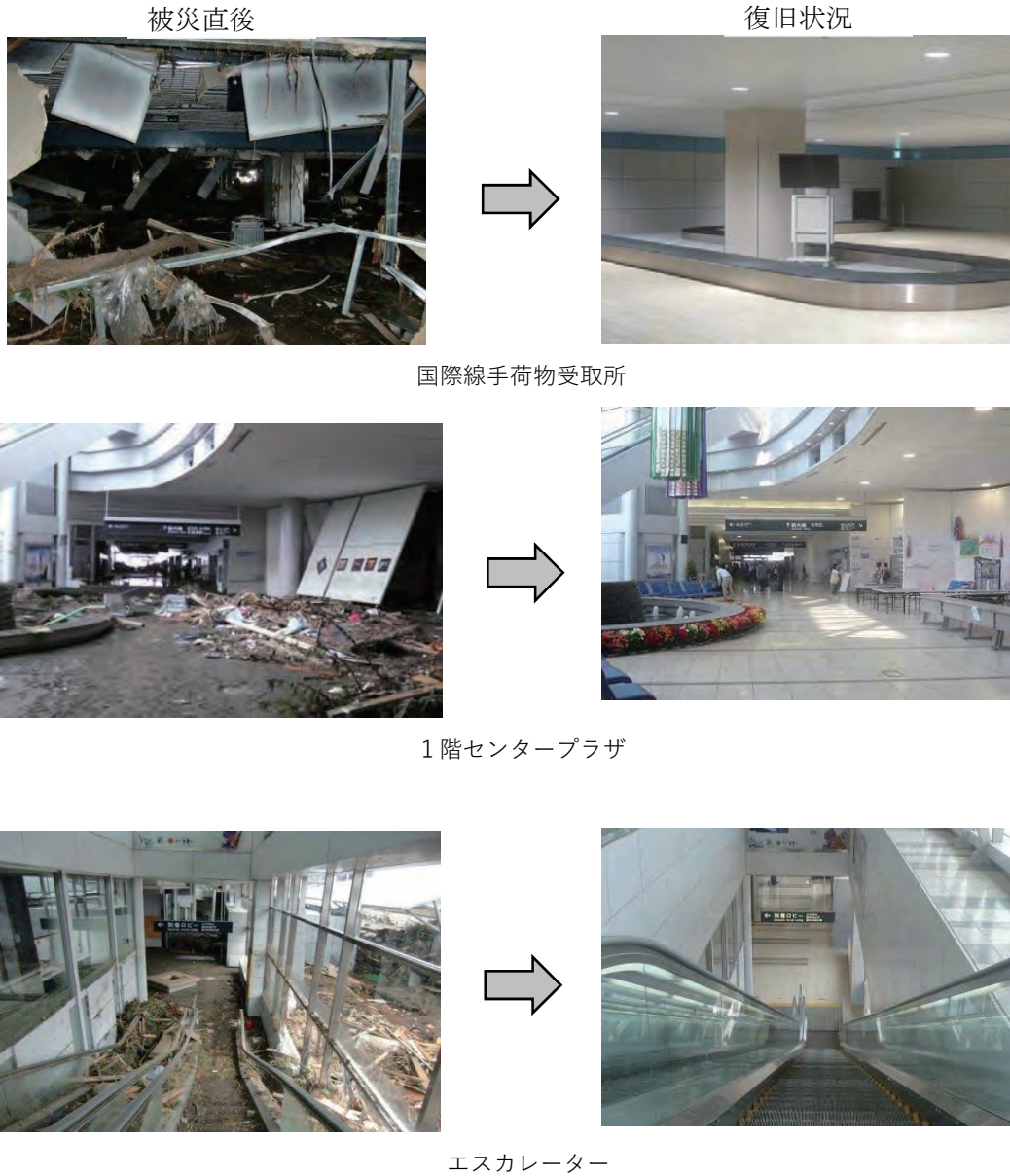
図 3-58 空港施設復旧状況
