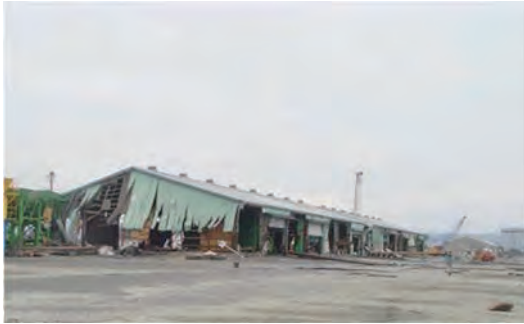
大手上屋（石巻港区） 施工前
