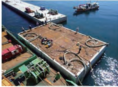
ケーソン据付
