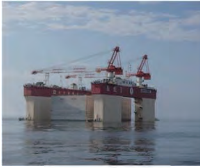
ケーソン進水
