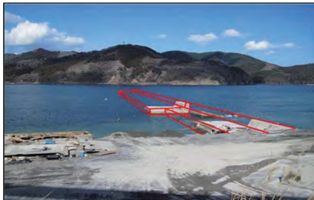
図 3-16 ケーソンが流出した南北防波堤
