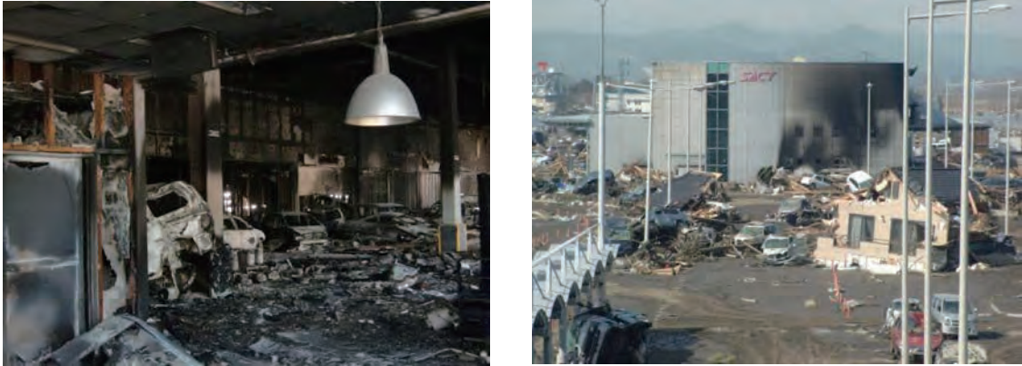
図 3-60 保税蔵置場（浸水した車両から引火し全焼）と施設全景
