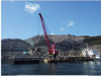
上部コンクリート打設
