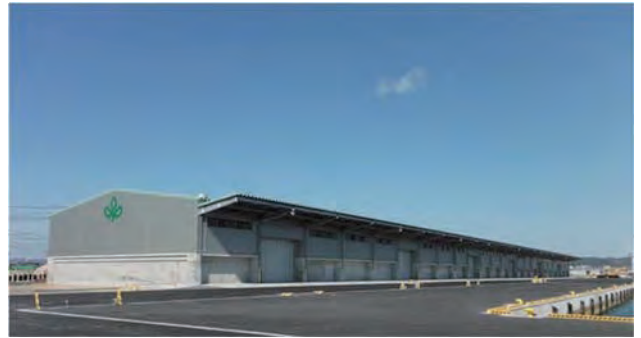
大手上屋（石巻港区） 施工後
