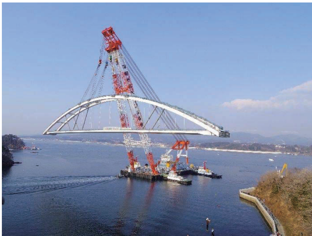
図 3-17 大島架橋上部工 地組状況
