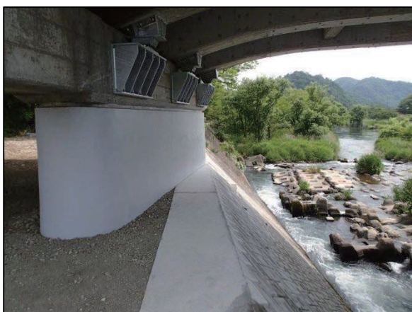
図 3-18 (主)岩沼蔵王線 宮大橋
