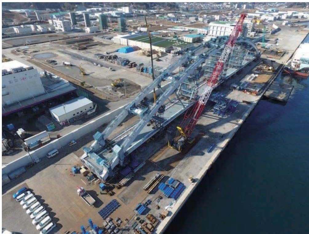
3-16 大島架橋上部工 仮設状況
