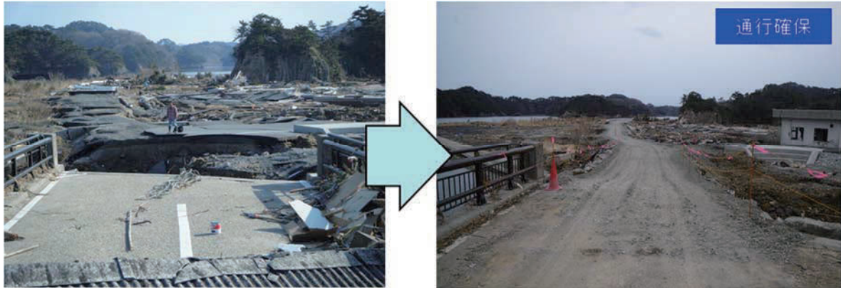
図 3-5 奥松島松島公園線 松ヶ島橋
