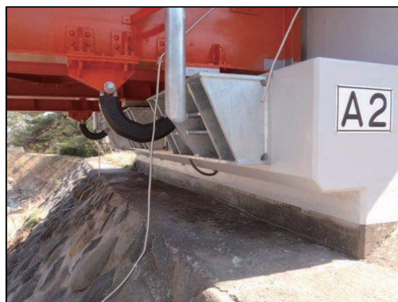
図 3-19 国道457号 遠刈田橋
