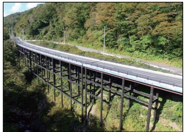
図 3-17 国道 347 号 宇津野 1 号 栈道工
