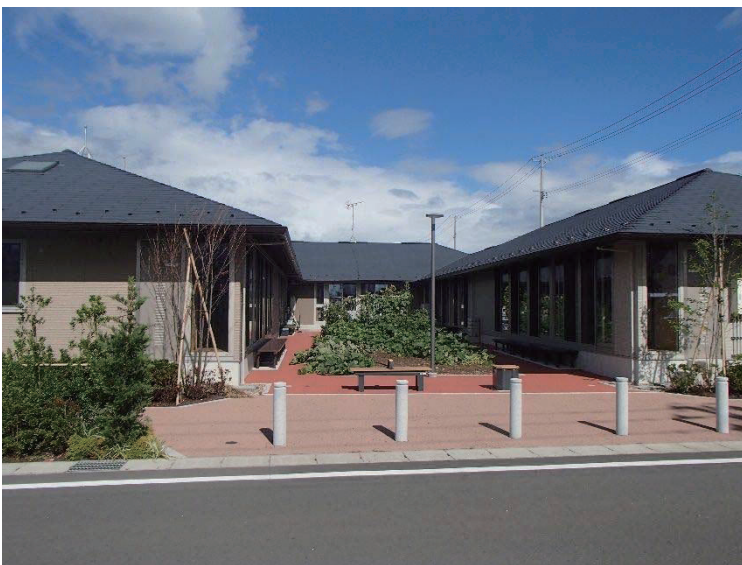
図 2-15084 新西前沼第三復興住宅 外観
