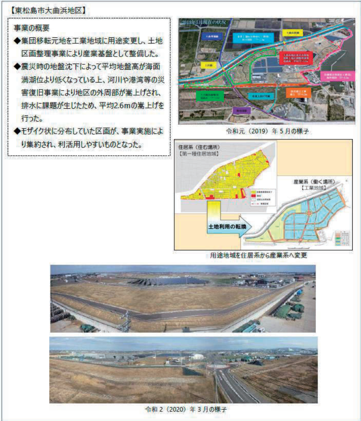
図 2-96 移転元地整備の事例
