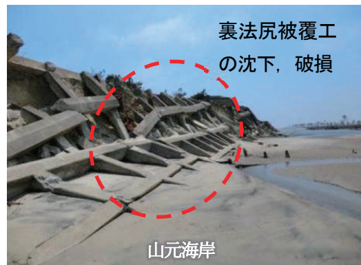
図 2-24 海岸堤防の被災事例
