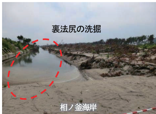
図 2-24 海岸堤防の被災事例
