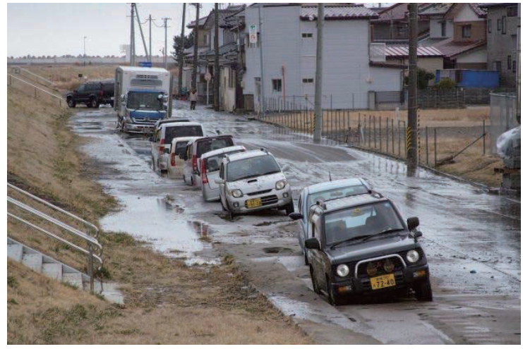
図 2-34 液状化の状況 (名取川周辺)
