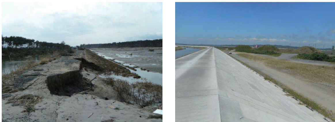
図 2-26 河川堤防の復旧事例（北上運河）
