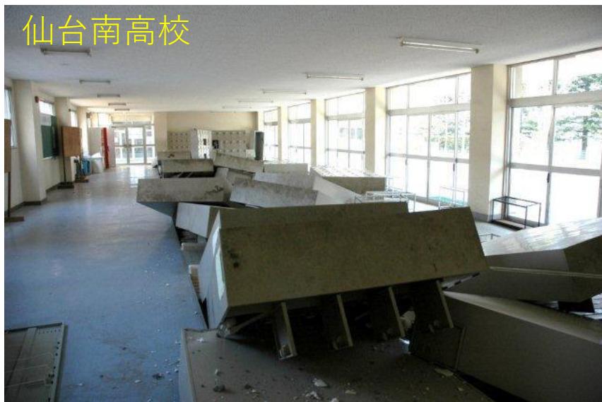
東日本大震災時の被害状況
