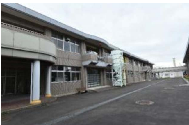
③ 3号館実習棟（運動場側から撮影）
