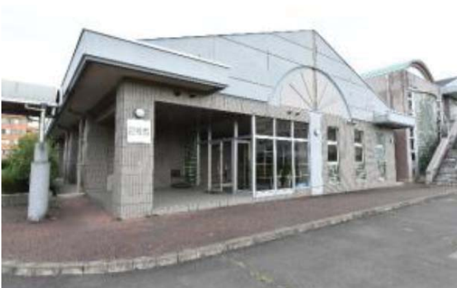
② 2号館実習棟（運動場側から撮影）
