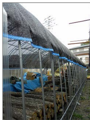
写真-20 寒冷紗の交換あり
